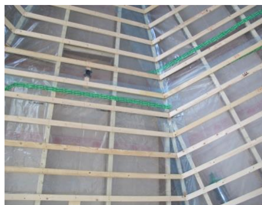
Bild 1. Parallelltak (Foto: Sjömarkens Isolering AB.)
