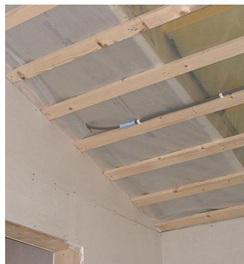
Bild 5. Otät genomföring i folien som definitivt inte kan accepteras. (Foto: Anneling Tobin Consult AB.)
